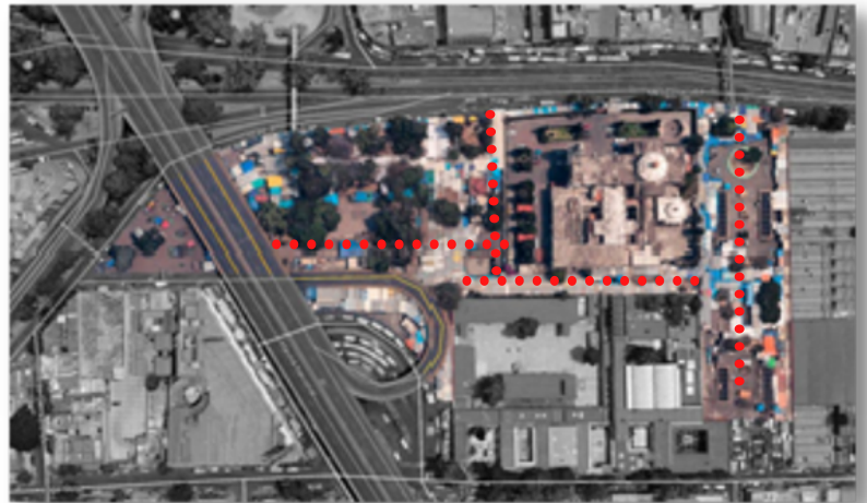
Fotografía aérea actual de Tacuba indicando las calzadas propuestas (Fuente google earth)
